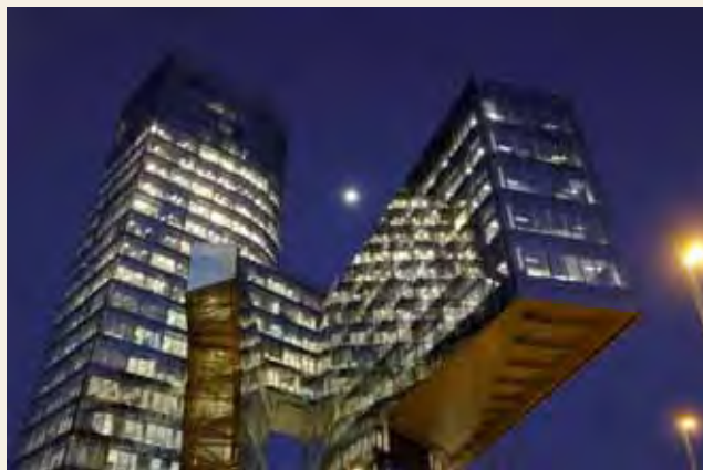
Metanero Sestao-Knutsen en construcción.
