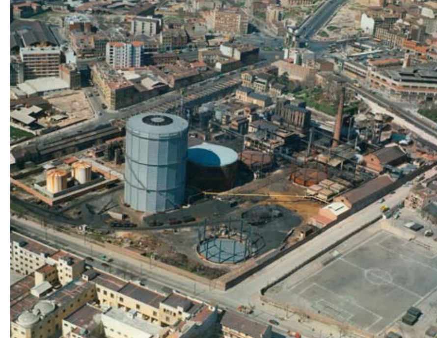
Panoramica dell'impianto di via Toledo.
