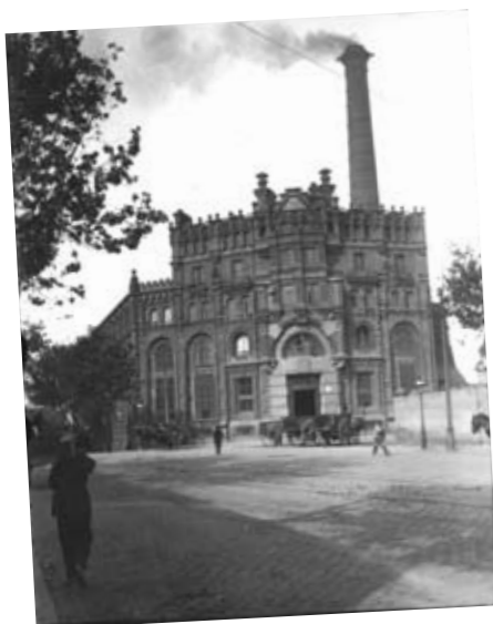
■ Centrale termica di Vilanova (Barcellona). 1896.
