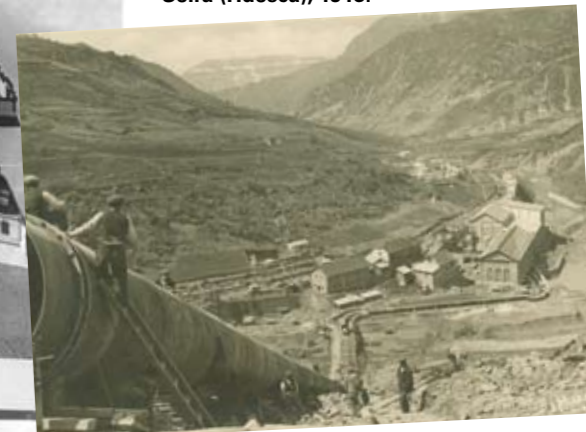
À esquerda, maquete da fábrica da Barceloneta, 1909. Abaixo, hidroelétrica de Seira (Huesca), 1918.
