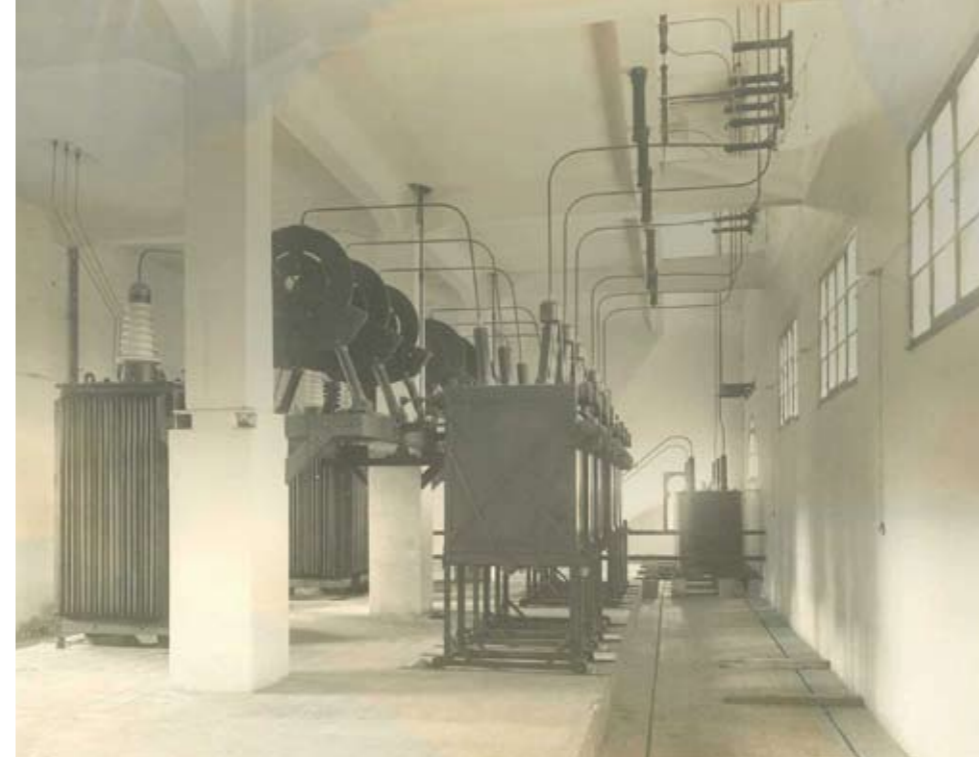
■ Interior de la subestación de Córdoba.
