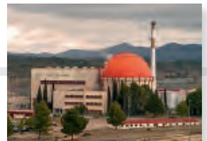
La centrale José Cabrera.
