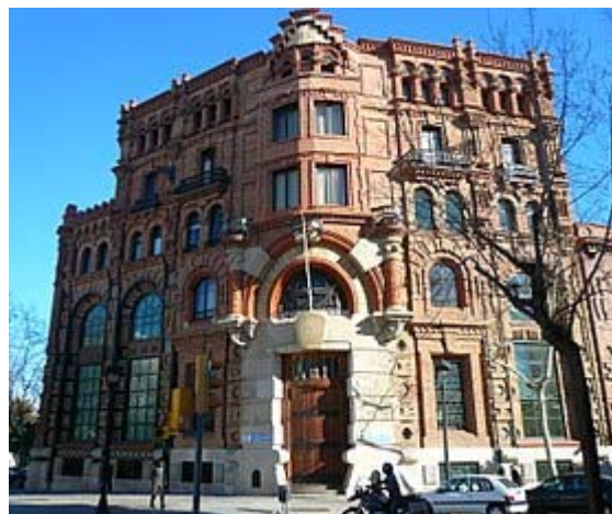
La antigua Central Vilanova, reconvertida en sede de Hidroeléctrica de Cataluña en los años 1980
