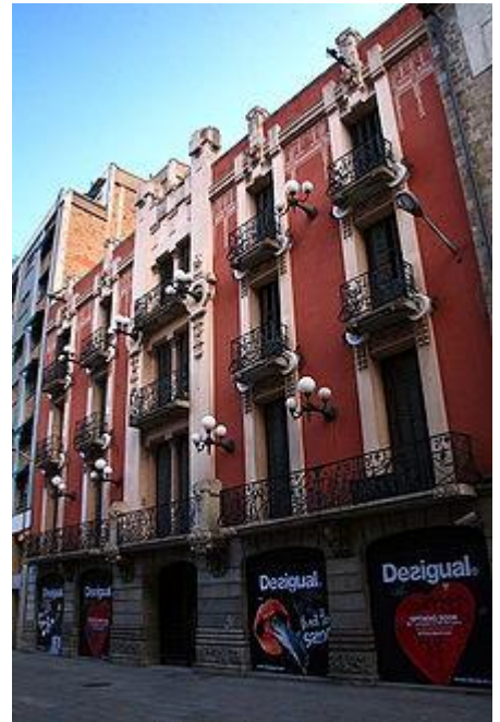
Edificio de calle Arcs, 10, de Barcelona, histórica sede de HECSA.
