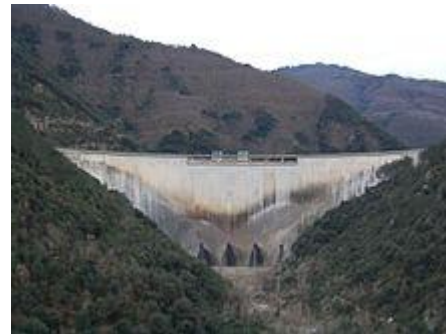
La presa de Susqueda, una de las obras hidroeléctricas destacadas de HECSA en la cuenta del Ter.
