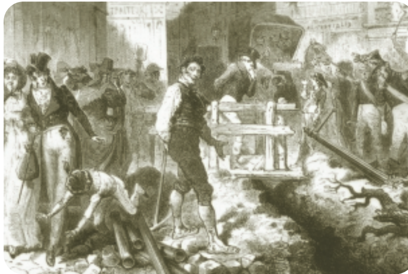
Obras en las calles de París para instalar canalizaciones de gas. 1820
