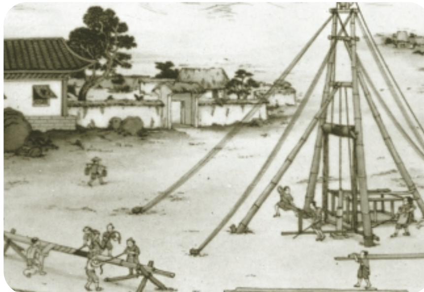
Instalación de una tubería de bambú por los chinos (siglo X)
