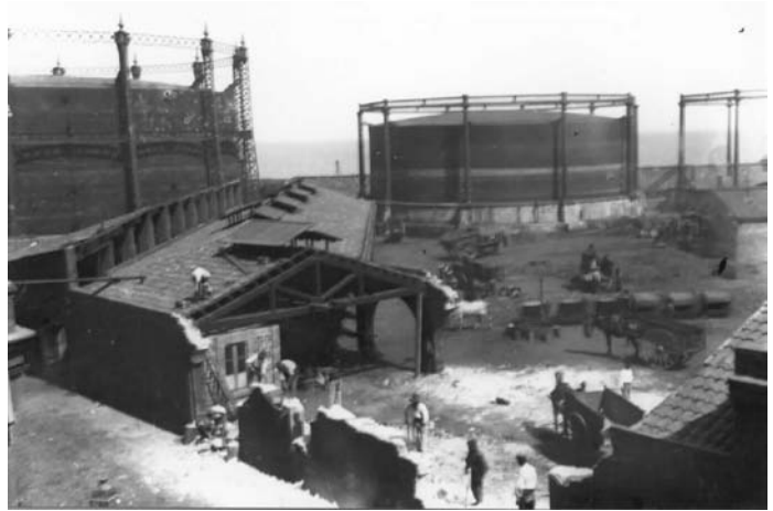
Fábrica de la Compañía de la Sociedad Catalana para el Alumbrado de Gas. AFGN.
