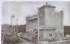
Subestación de Córdoba
