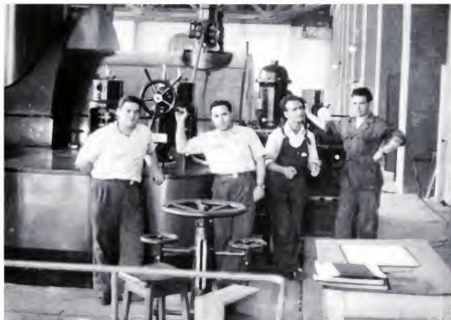
Cabeza de máquina nº 23, reparación y pruebas
