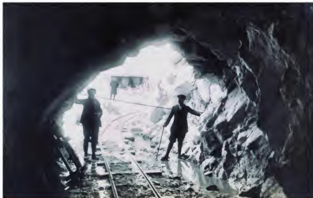
Túnel de camino de acceso a la cámara de agua en el lago helado de Estangento
