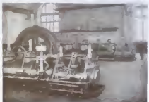
Central eléctrica del Valle de las Ollas
