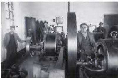
Trabajadores en la sala de turbinas, 1943
