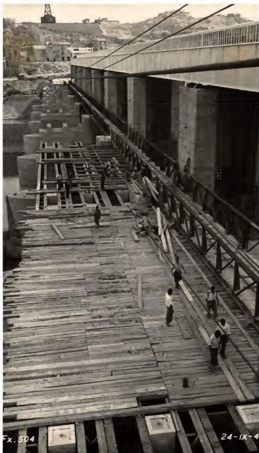
Zona de la presa, vistas generales de la presa
