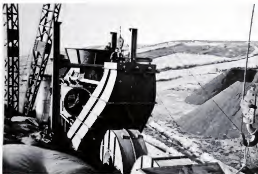
Montaje ventiladores de tiro inducido
