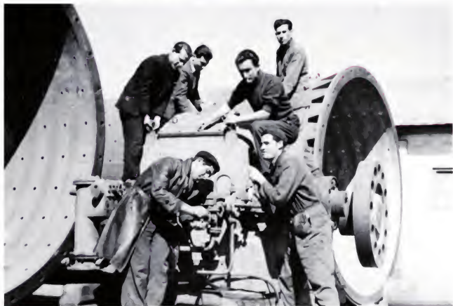
Montando reductora molino.
