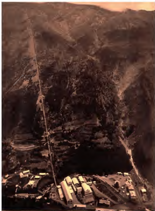
Instalaciones en el lago regulador Estargento.
