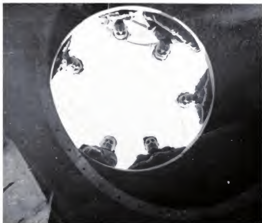
Montando tubo en chimenea.
