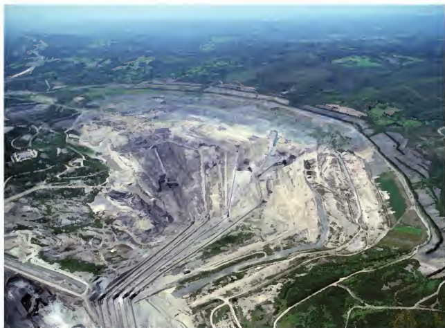
Vista del Campo Oeste. 2005.
