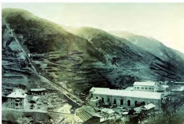
Central hidroeléctrica de Cabdella. Vista panorámica parcial.
