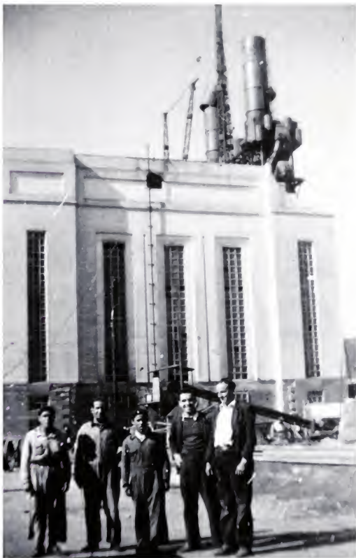
Construyendo y montando tubos de la chimenea. 2ª fase
