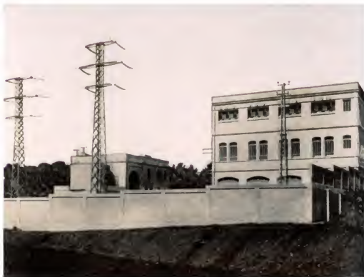
Vistas de la estación transformadora de Casa Barba y Marrosa
