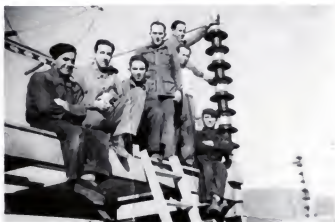
Montaje parque de alta tensión
