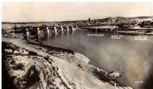
Vistas generales de la presa de Flix en fase de construcción.
