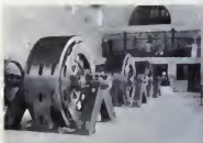
Bata de Corchado. Año de instalación.
