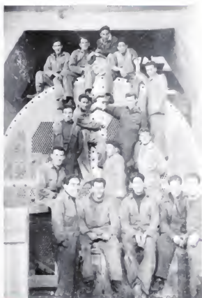
Montaje de condensador máquina 4
