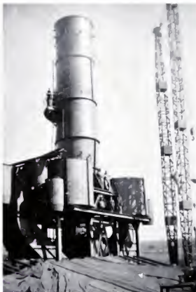
Montando la estructura de conductos de chimeneas.
