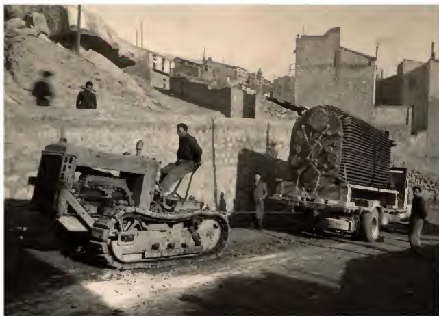
Zona de la central, tanque transformador de 2.500 KVA 110/25 KV de 7 toneladas.
