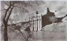
Central hidroeléctrica de El Cuyo
