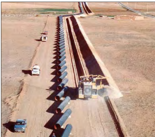
Colocación de los tubos y ejecución de la zanja (Gas Natural SDG, S.A.-ENAGAS).
