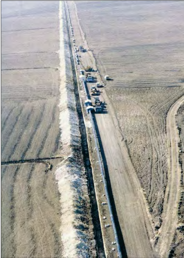
Gasoducto en construcción (Gas Actual, nº 106, feb. 2008: 34).
