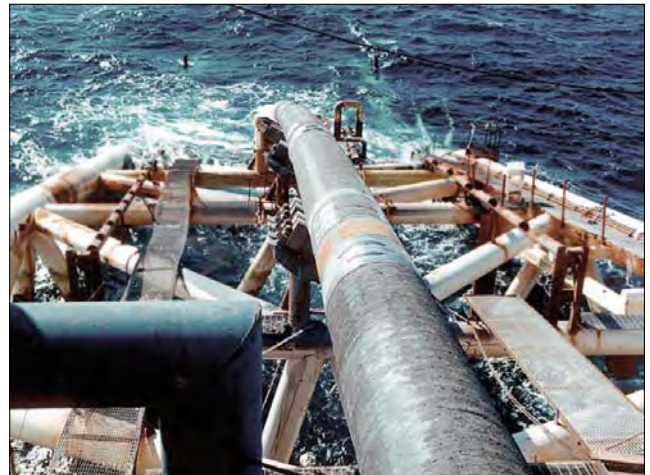
Tendido del gasoducto de 42" de diámetro del proyecto Langeled en el Mar del Norte (EUROPIPE).
