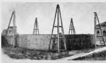
FIG. 27. — Premier gazomètre comportant des chevalements en bois. Diamètre : 15,20 m ; hauteur : 5,50 m ; volume : 990 m 3 . Usine à Gaz de Fulham-Station, 1829, encore en service en 1859.
