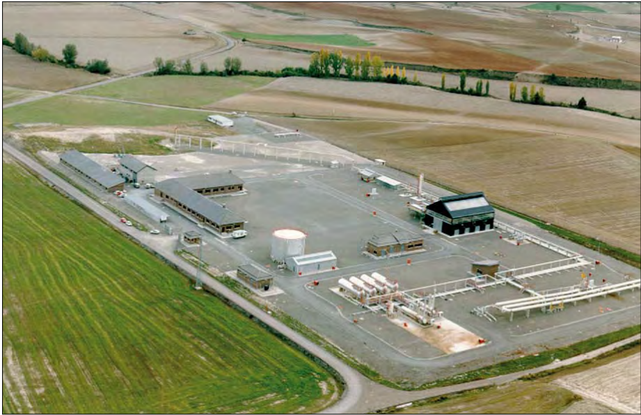
Planta de almacenamiento de Serrablo (Gas Natural SDG, S.A.).
