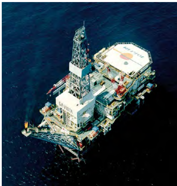
Vista aérea de la plataforma del yacimiento Gaviota. Fuente: (Gas Natural SDG, S.A.).
