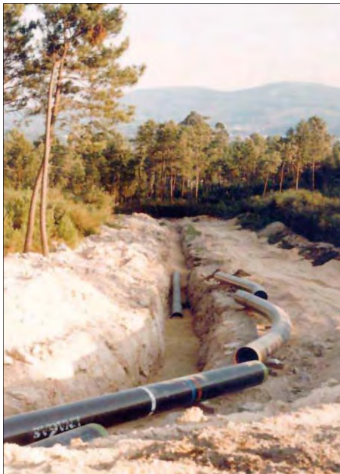
Canalización de tubería de acero, sistema de zanja y tubos preparados para la soldadura (Gas Natural S.D.G.).
