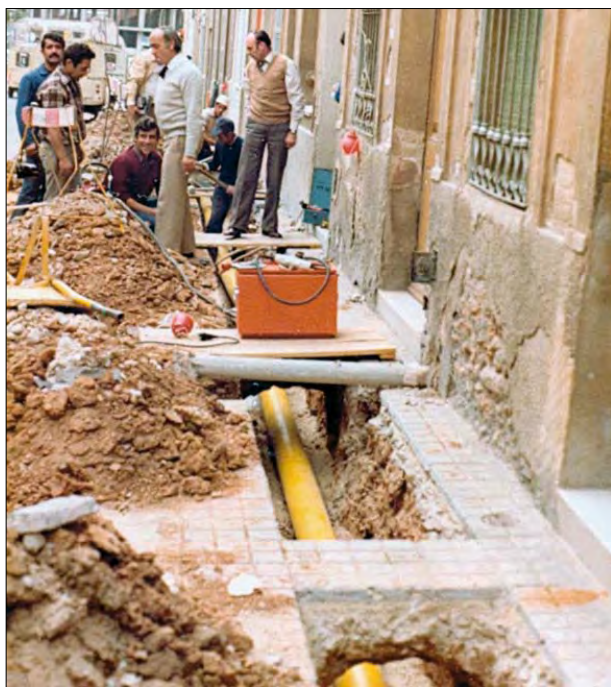
Canalización de una de las primeras tuberías de polietileno en baja presión instalada en España en el año 1980 en la ciudad de Sabadell (J.Mata).
