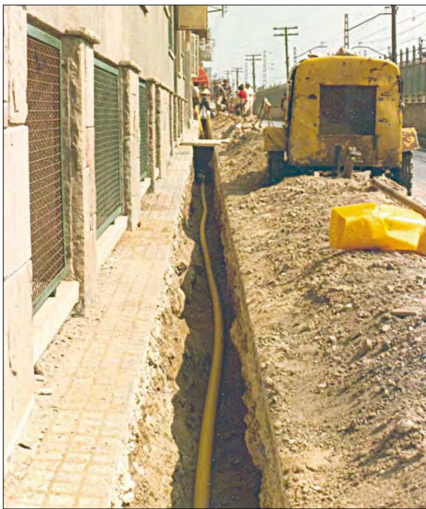
Una de las primeras canalizaciones de polietileno de España en la red de gas natural de Montcada y Reixach, año 1980 (J. Mata).
