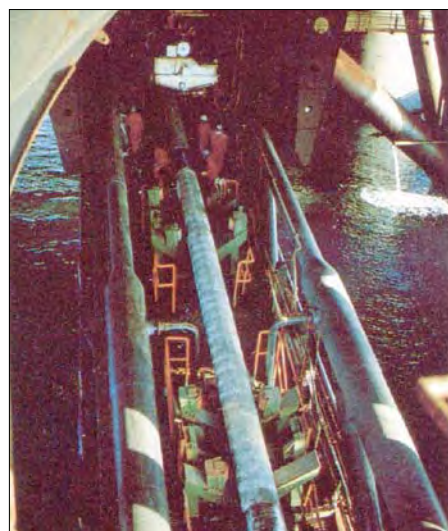
Rampa de tendido de la línea submarina (Gas Natural SDG, S.A. – ENAGAS).
