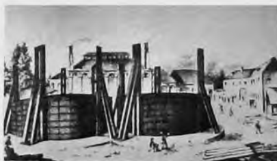
FIG. 28. — Les deux premiers gazomètres de l'Usine à Gaz de Cologne. Cuve enterrée ; chevalement bois, Construction : 1840-1841.
