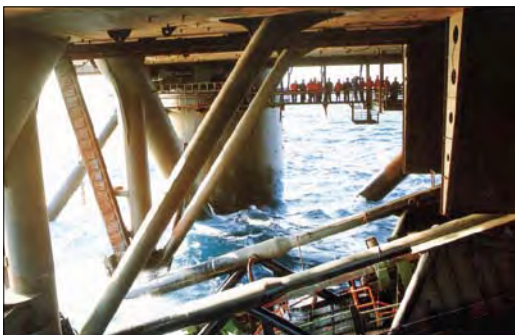
Rampa de tendido de la línea submarina (Gas Natural SDG, S.A. – ENAGAS).
