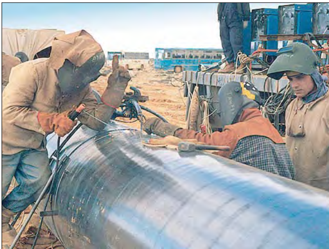
Soldadura de tubo en un gasoducto en Qatar (EUROPIPE).
