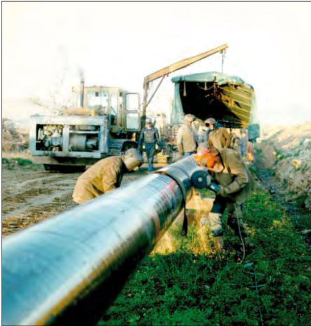
Soldadura de tubo de acero (Gas Natural, S.A.).
