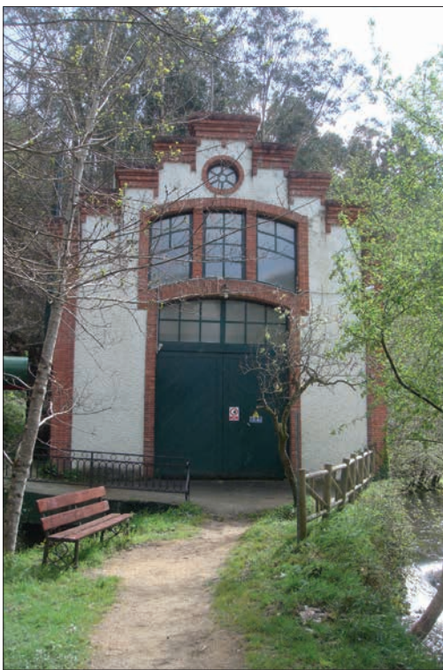
Edificio de la antigua central hidroeléctrica de José Barro en la localidad lucense de Chavín (Viveiro). Año 2012. Fuente: fotografía Xoa Carmona.
