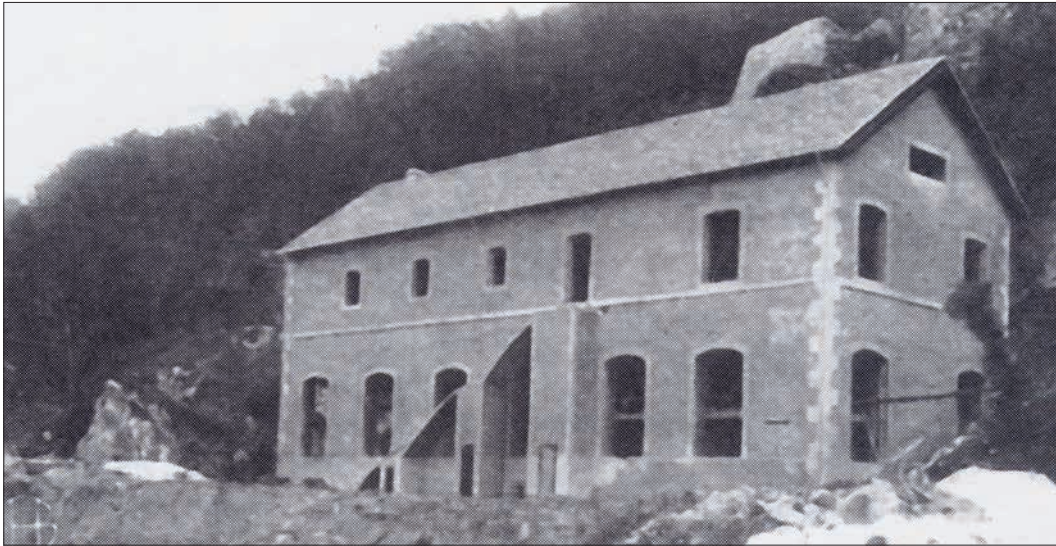
Casa de máquinas de la central de Toxa (Merza), en el río de igual nombre, para la Cooperativa Eléctrica Santiaguesa. Fuente: Vida gallega, nº 147 (1920). © Galiciana. Biblioteca Dixital de Galicia.
