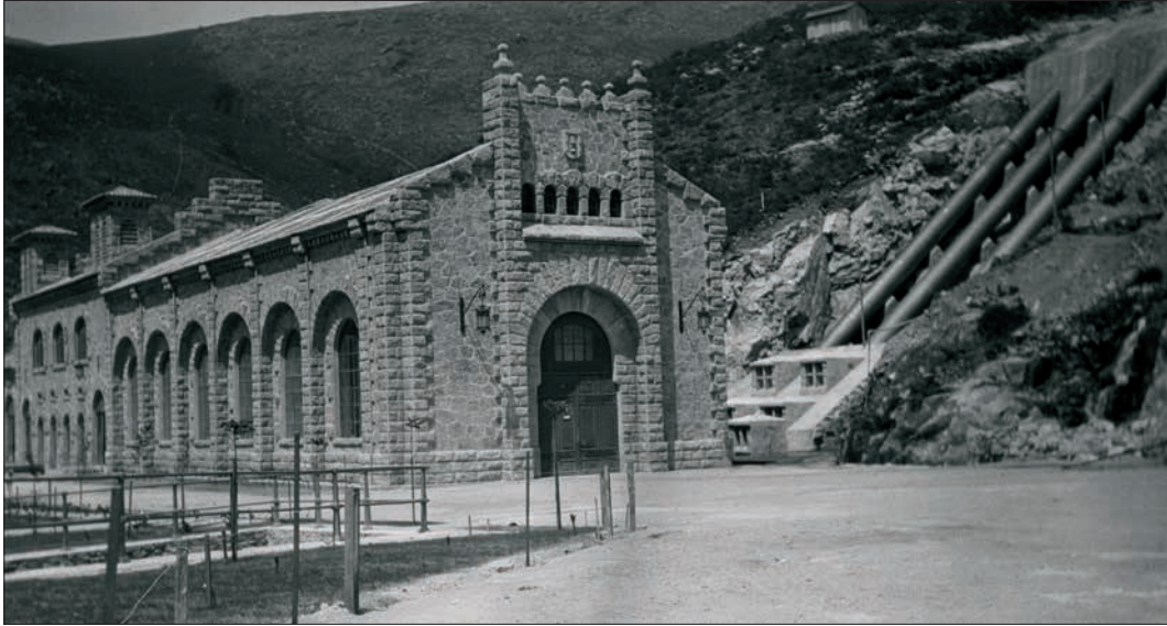
Central del Tambre en construcción. C. 1927. Fuente: Archivo do Reino de Galicia. Colección fotográfica. Signatura 423.
