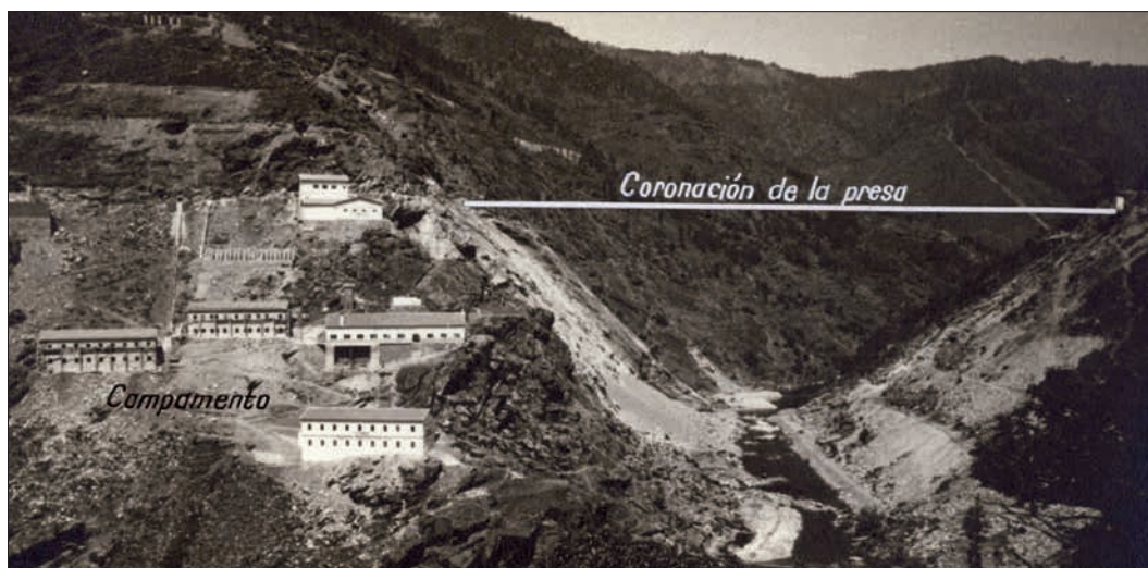
Vista de las obras de construcción del poblado para los trabajadores de la presa e indicación de su localización sobre foto de la presa. Año 1943. Fuente: AHFB.
