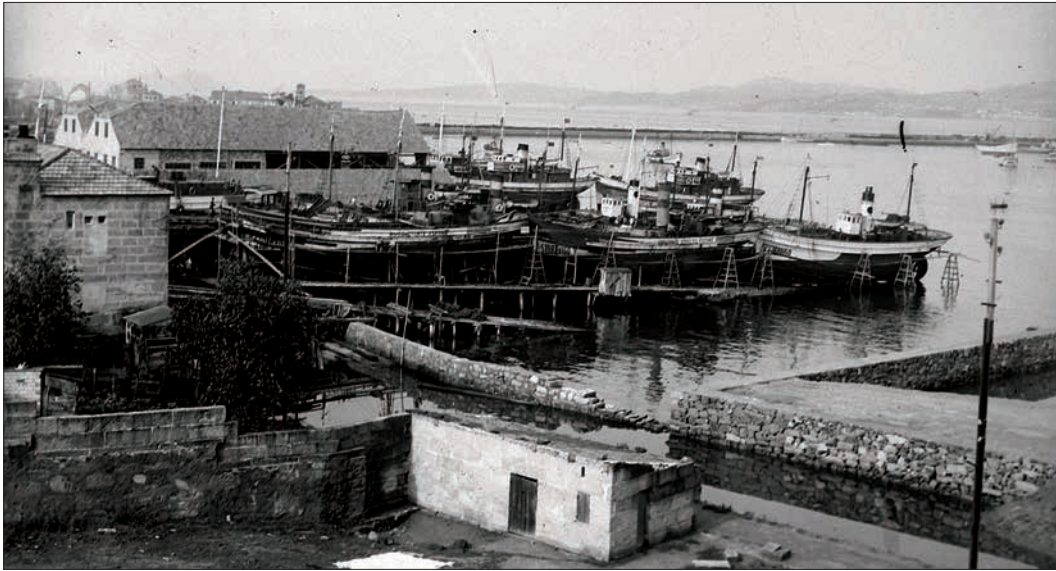
Hijos de J. Barreras era el mayor de los astilleros vigueses a la altura de 1929, y sería el primero en introducir la soldadura eléctrica. C. 1929.
