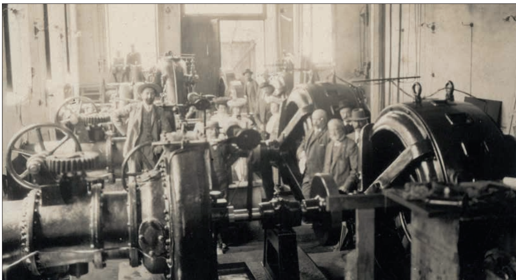
Interior de la central hidroeléctrica de Segade. C. 1902. Fuente: AHFB.
