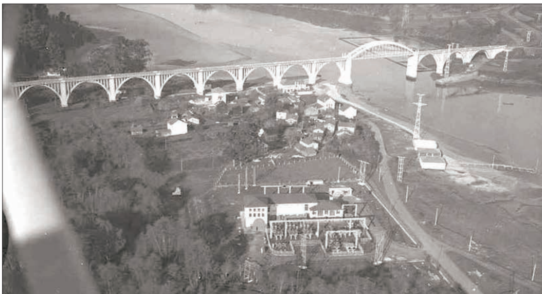
Estación de transformación de Ponte Pedrido. C. 1967. Fuente: FOAT.
