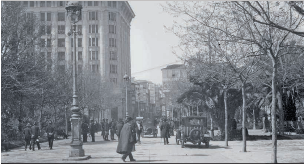
Edificio del Banco Pastor en A Coruña. C. 1930. Fuente: Arquivo do Reino de Galicia. Colección fotográfica. Signatura 974.
