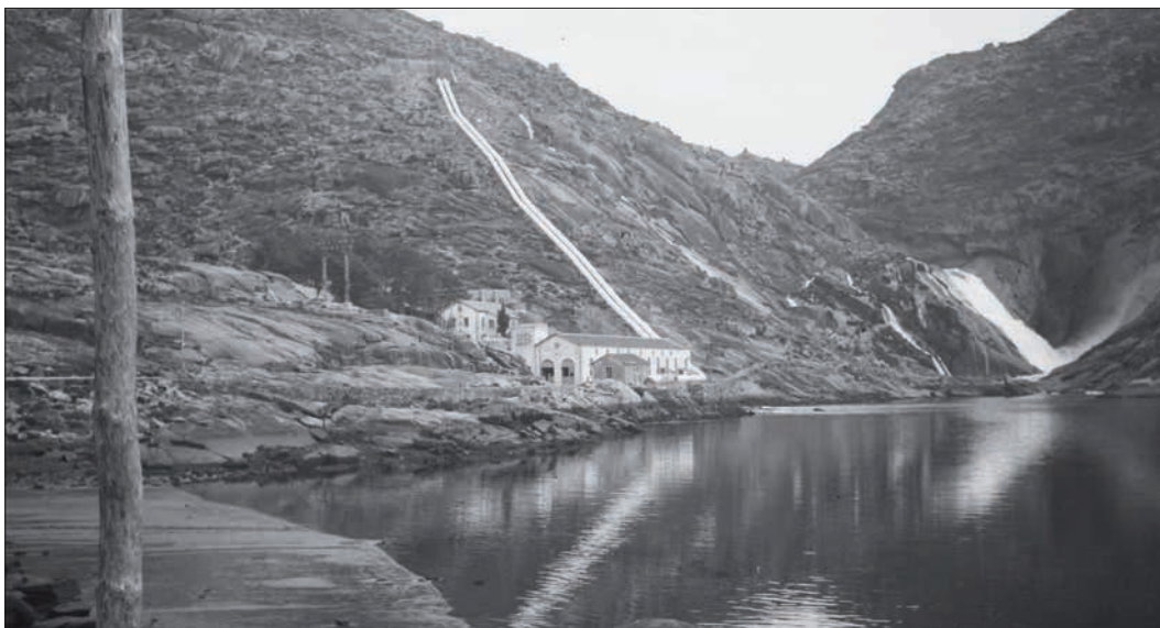
Central de la Hidroeléctrica del Pindo, en la desembocadura del río Xallas. Año 1910. Fuente: Archivo do Reino de Galicia. Colección fotográfica. Signatura 347.
