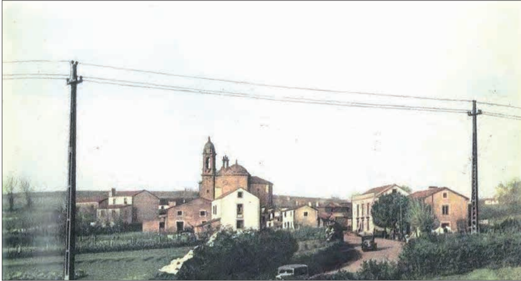
Línea con postes de cemento (15 kV) de FCGE. Año 1945. Fuente: SEMI (1949).
