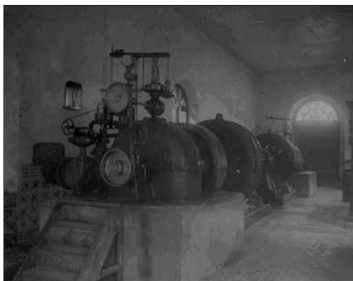
Central de A Fervenza. Sala de máquinas. Año 1903. Fuente: AHFB.
