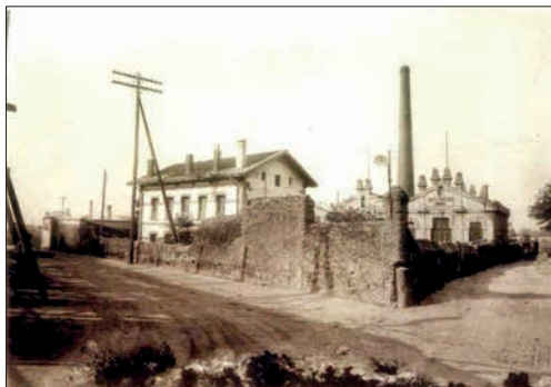
Central térmica de reserva y oficinas de la SGES en Santiago, en la esquina de lo que hoy son las calles General Pardiñas y Montero Ríos. Año 1925. Fuente: AHFGNF-Antiguo Archivo Unión Fenosa.
