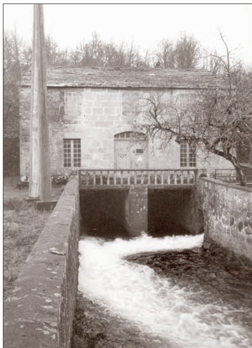
Antigua central hidroeléctrica de San Xoán de Muro, que había sido construida por Martínez Hermanos. Año 1986.
