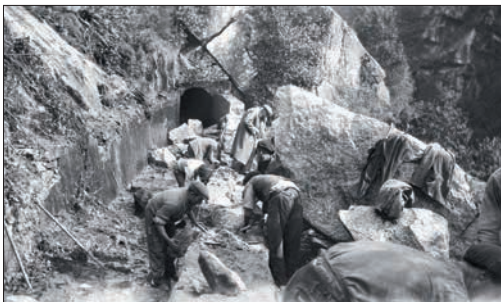
Obras de construcción del canal de la central de Ventureira. Año 1903. Fuente: Arquivo do Reino de Galicia. Colección fotográfica. Signatura 391.
