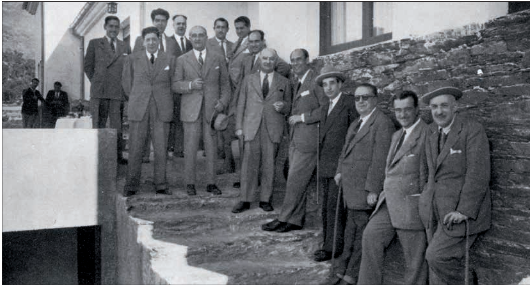
En esta foto del año 1946, tomada con ocasión de una visita del Consejo de Administración de Fenosa a las obras de As Conchas, se visualizan las relaciones de cooperación que presidieron la puesta en explotación de la cuenca Miño-Sil. El cuarto por la derecha es Ignacio Villalonga. El quinto, Marcelino Botín Sanz de Satuola, y el sexto, Pedro Barrié de la Maza.
