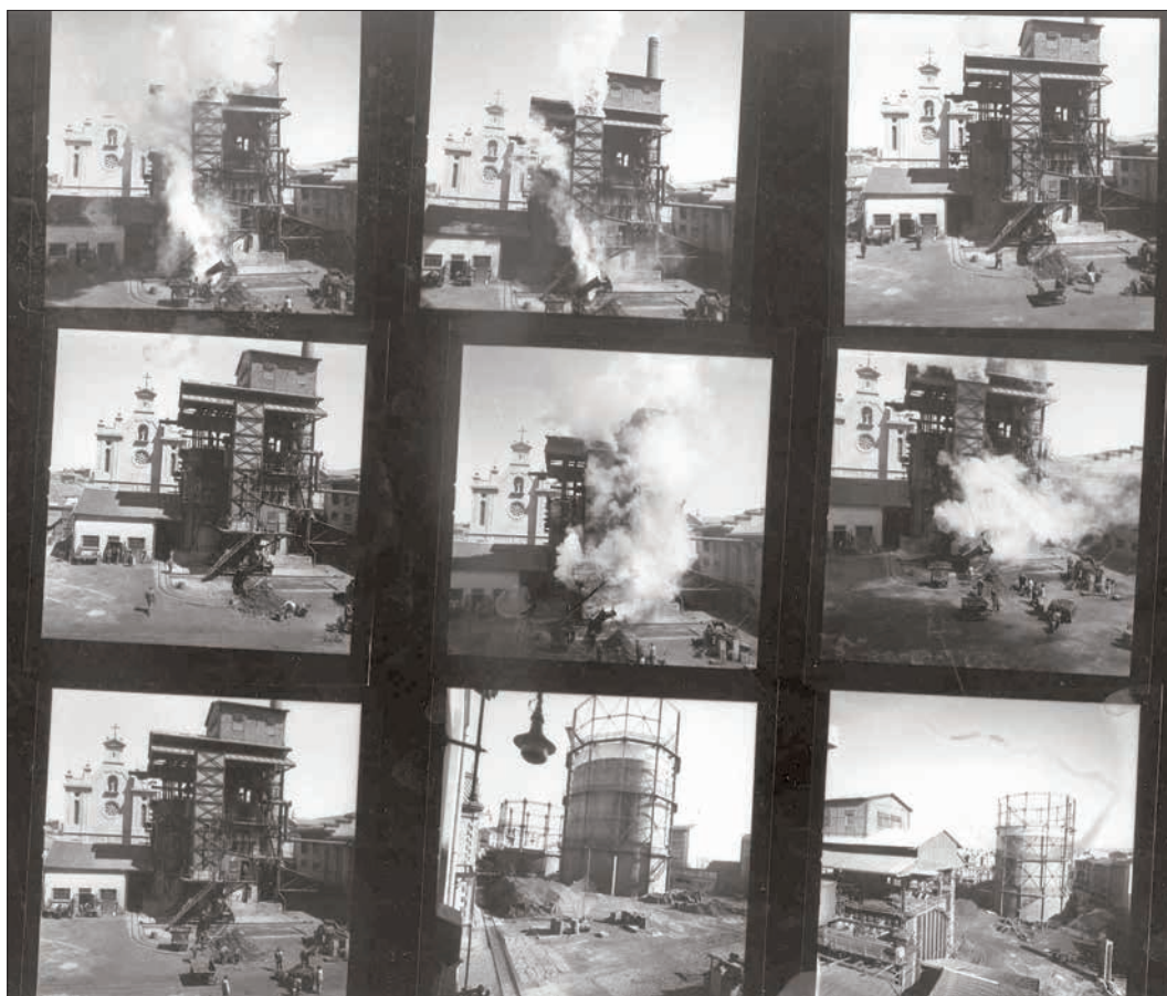
Fábrica de gas de A Coruña. C. 1950. Fuente: AHFGNF-Antiguo Archivo Unión Fenosa.
