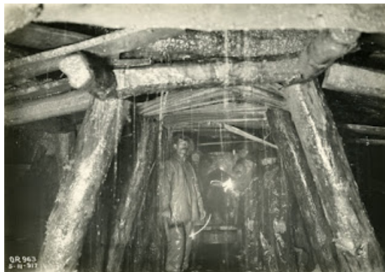
Las filtraciones de agua complican las duras condiciones de trabajo de los mineros. Un grupo está preparado para colocar una cimbra y así poder revestir el túnel. 5 de marzo de 1917.
