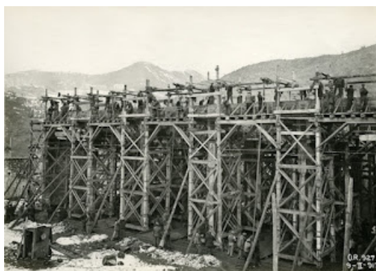
Hormigonado de las vigas de la sala de transformadores. Seira. 9 de febrero de 1917.
