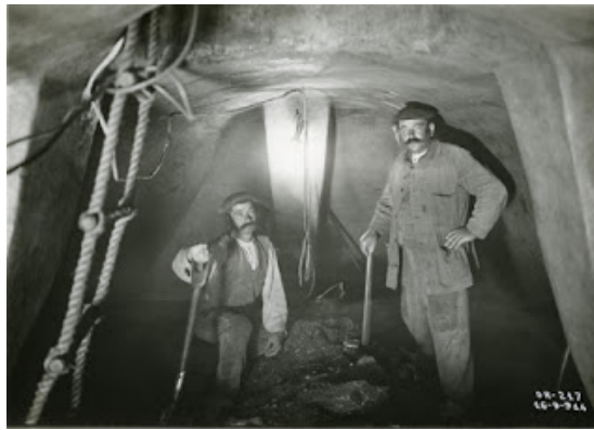
Dos obreros en el interior de la cámara de trabajo del cajón número 1. La escala es el único nexo de unión que tienen con el exterior. Villanova. 16 de septiembre de 1914.
