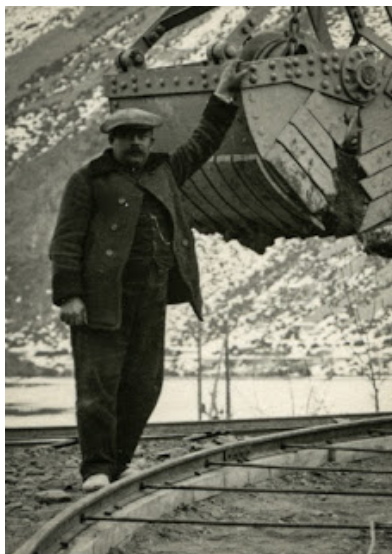
Draga eléctrica dispuesta para profundizar el cauce del río en el emplazamiento de la presa. Villanova. 17 de marzo de 1915.
