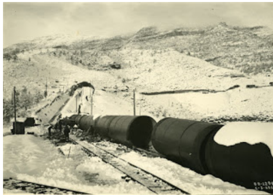
Las tuberías, bajo una intensa nevada, listas para su instalación. Seira. 1 de enero de 1918.
