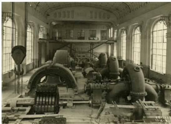
Montaje del alternador número 2. En primer plano el rotor sin sus polos. 11 de mayo de 1918
